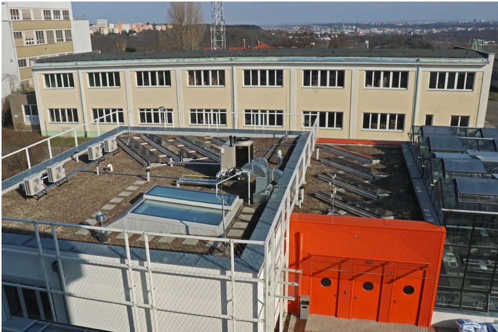
Střecha ubytovací části (vlevo) a přípravný skleníku s fotovoltaickými panely
