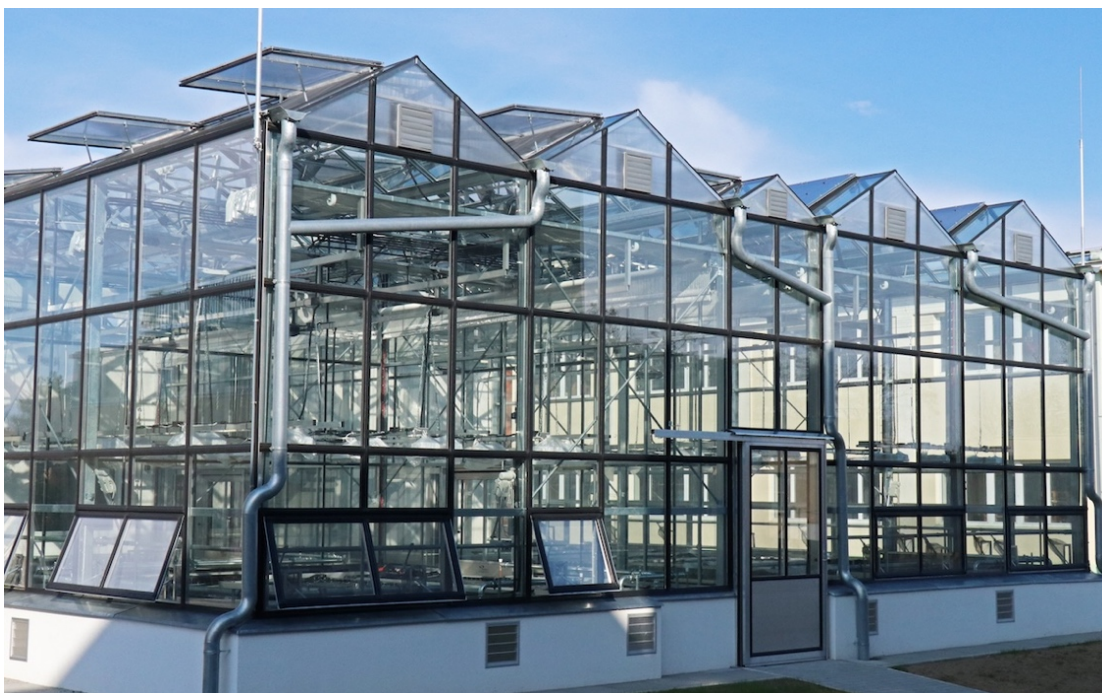
Pohled na skleníkovou část stavby
