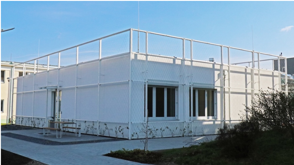
Ubytovací část stavby
